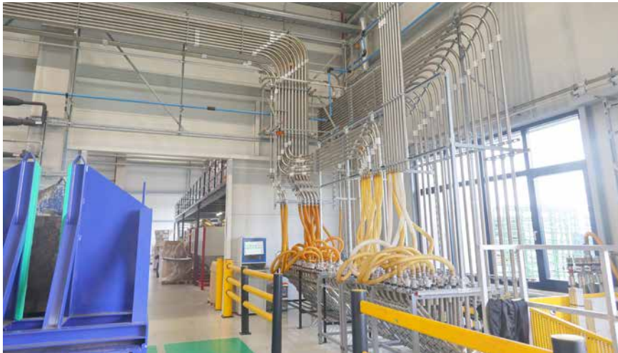
Der voll digitalisierte Materialbahnhof im neuen Werk von Gerhardi ist ein wesentlicher Erfolgsfaktor. Die nachhaltige Materialtrocknung und -logistik stammt komplett von Wenz.
